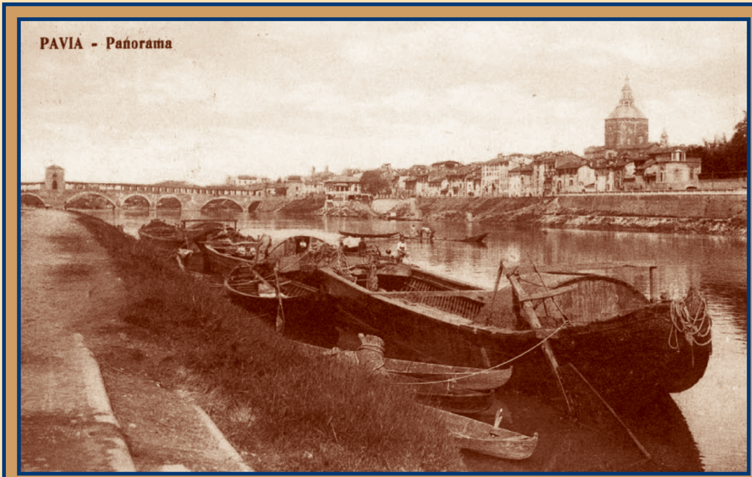
1926 - Pavia. Tipiche imbarcazioni pavesi ormeggiate lungo la riva di Borgo Basso. In primo piano la massiccia poppa della nave pavese o magano con il timone laterale e la cabina ad arco per l'equipaggio.
