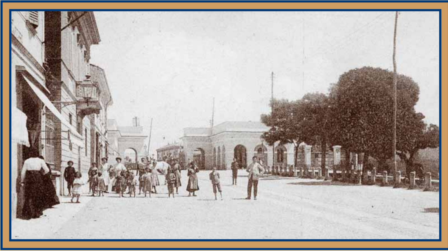
Anno 1911. Porta Cairoli. Per i vecchi pavesi è "Porta Stopa" dal dialetto "stupà", cioè chiusa. Quando la Porta di San Vito (oggi Porta Milano) fu aperta nel 1784 si decise di chiudere quella che allora era di Santa Maria delle Pertiche acquisendo la denominazione popolare di "Porta Stopa". Insorsero contro questa decisione gli operatori economici della zona e così la porta, in seguito, fu riaperta. Dopo il Risorgimento la porta fu intitolata ai Cairoli che tanta parte ebbero nel movimento per l'Unità d'Italia. Nell'immagine si scorgono il porticato degli uffici daziari ed i cancelli di chiusura.
