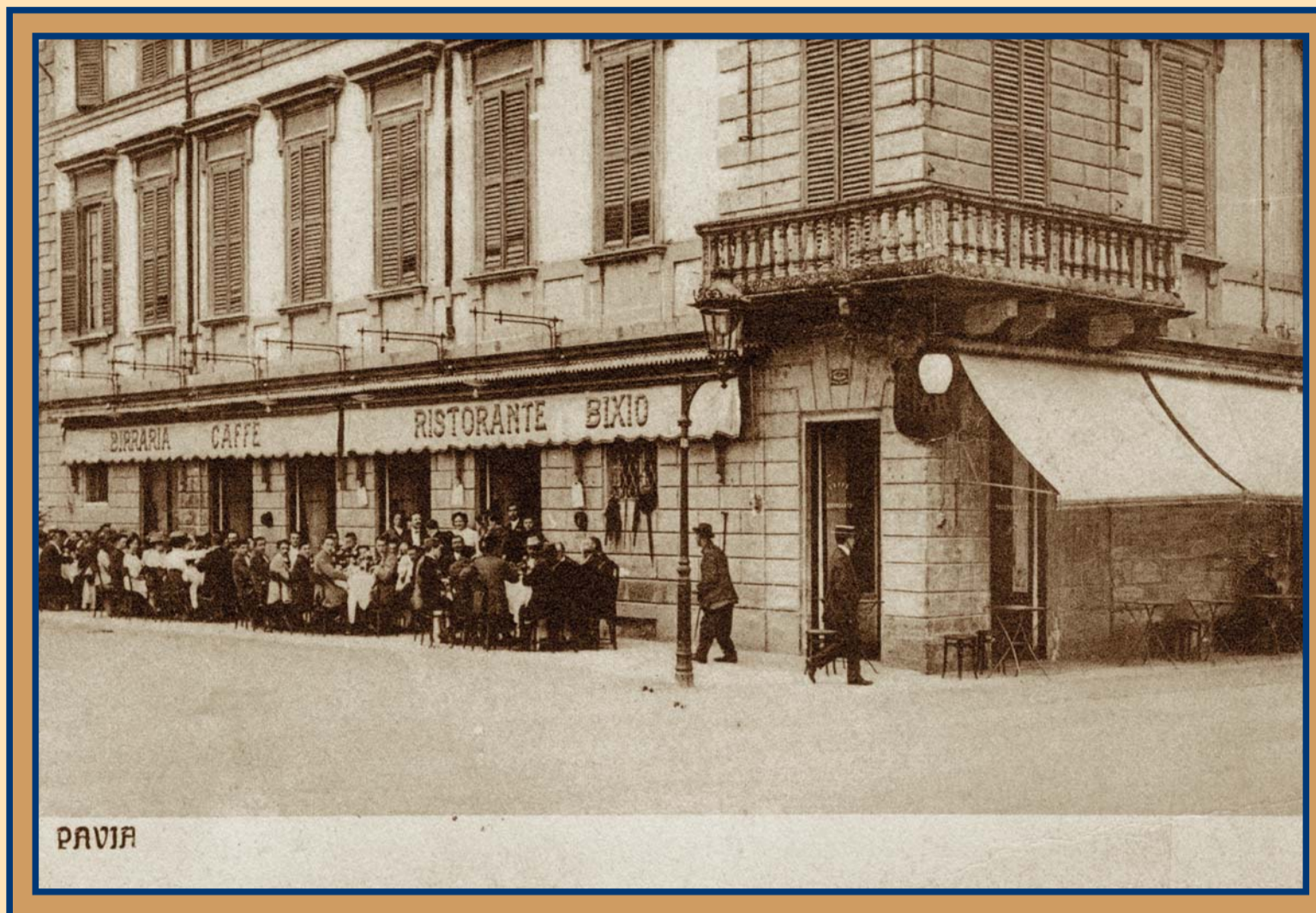
1913 - Caffè ristorante Bixio; situato nei locali di Casa Cairoli, all'angolo di Piazza Castello e l'imbocco di Strada Nuova (l'antico Corso Vittorio Emanuele) fu uno dei più famosi e storici ristoranti della città. Le sue eleganti sale hanno ospitato ricevimenti e banchetti di ogni genere scandendo la vita di Pavia e dei pavesi.
