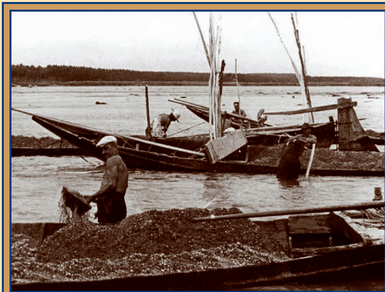
Cavatori caricano di ghiaia il barcone (mutaiö) mediante il cuciar, un grosso mestolo forato, 1960 ca.
