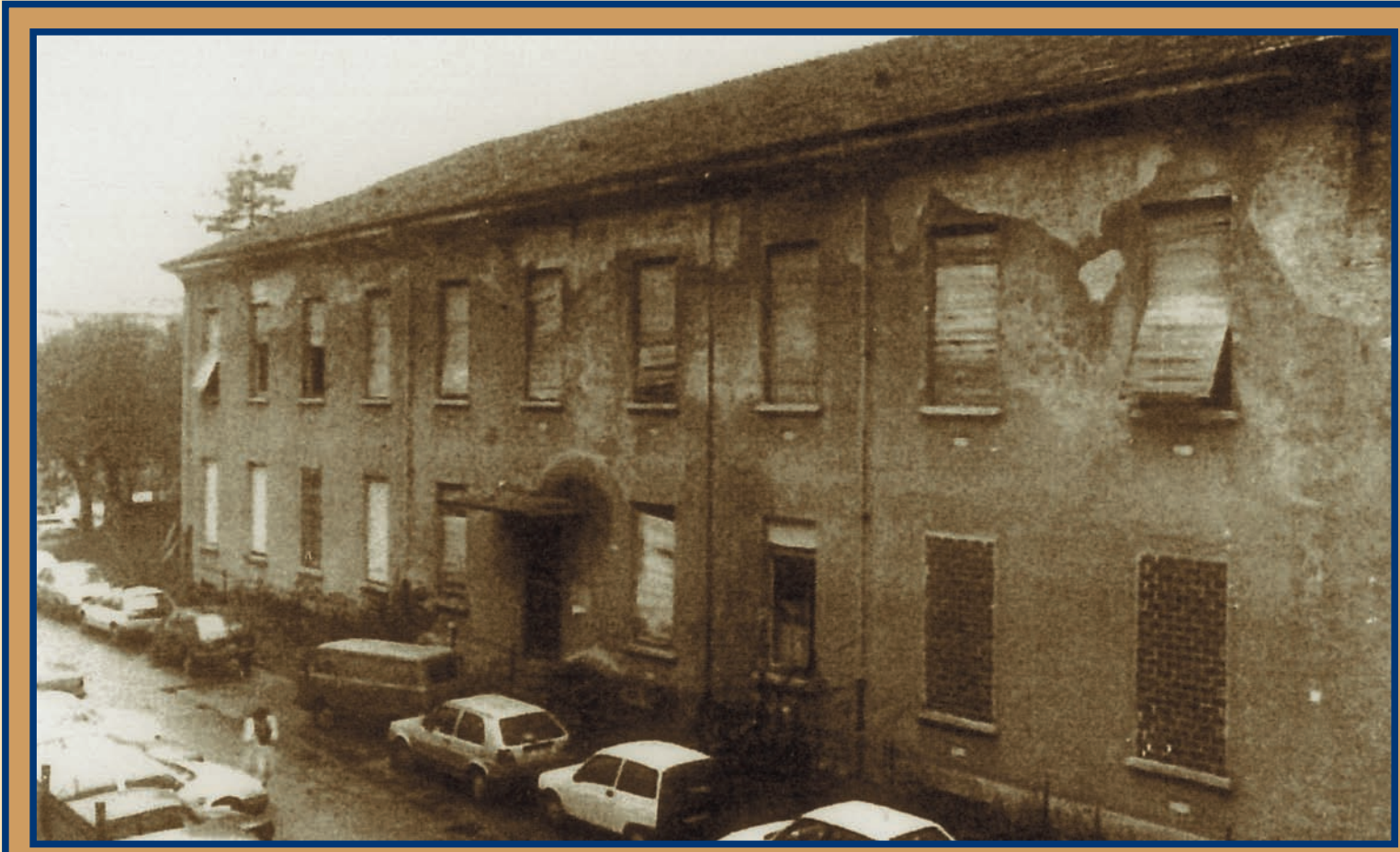
L'edificio del "Sequestro" prima della sua demolizione avvenuta alla fine degli anni 80; nella stessa sede venne poi costruita la Clinica Ematologica.
