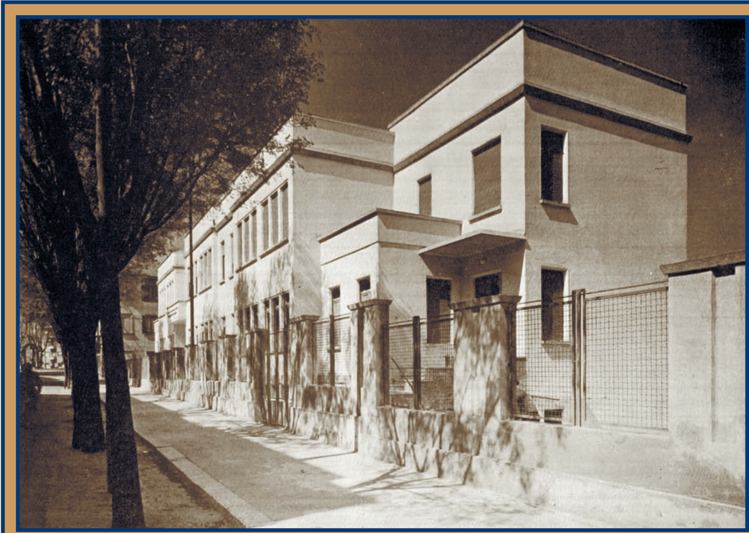
La sede del Dispensario di Pavia in viale Gorizia; il trasferimento dai locali di piazza Borromeo (presso l'Istituto Forlanini) avvenne a ridosso dello scoppio della seconda guerra mondiale. La sede di viale Gorizia fu ampliata nel 1956.
