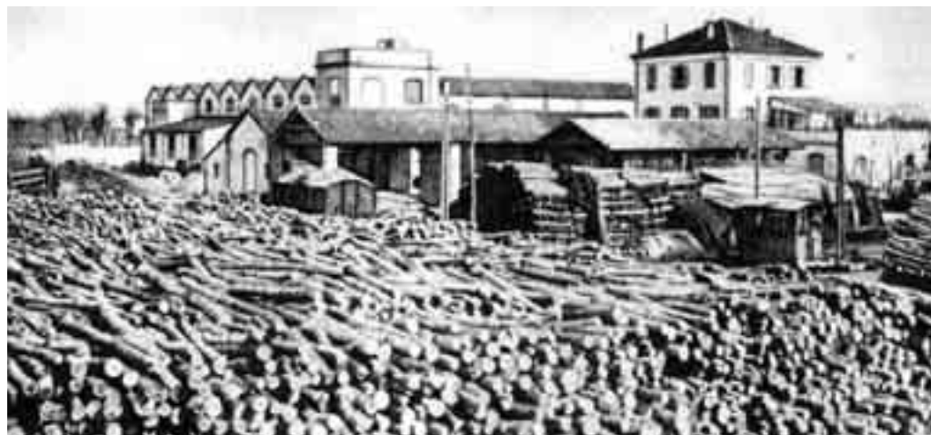
Fabbrica pasta di legno - Pavia.
