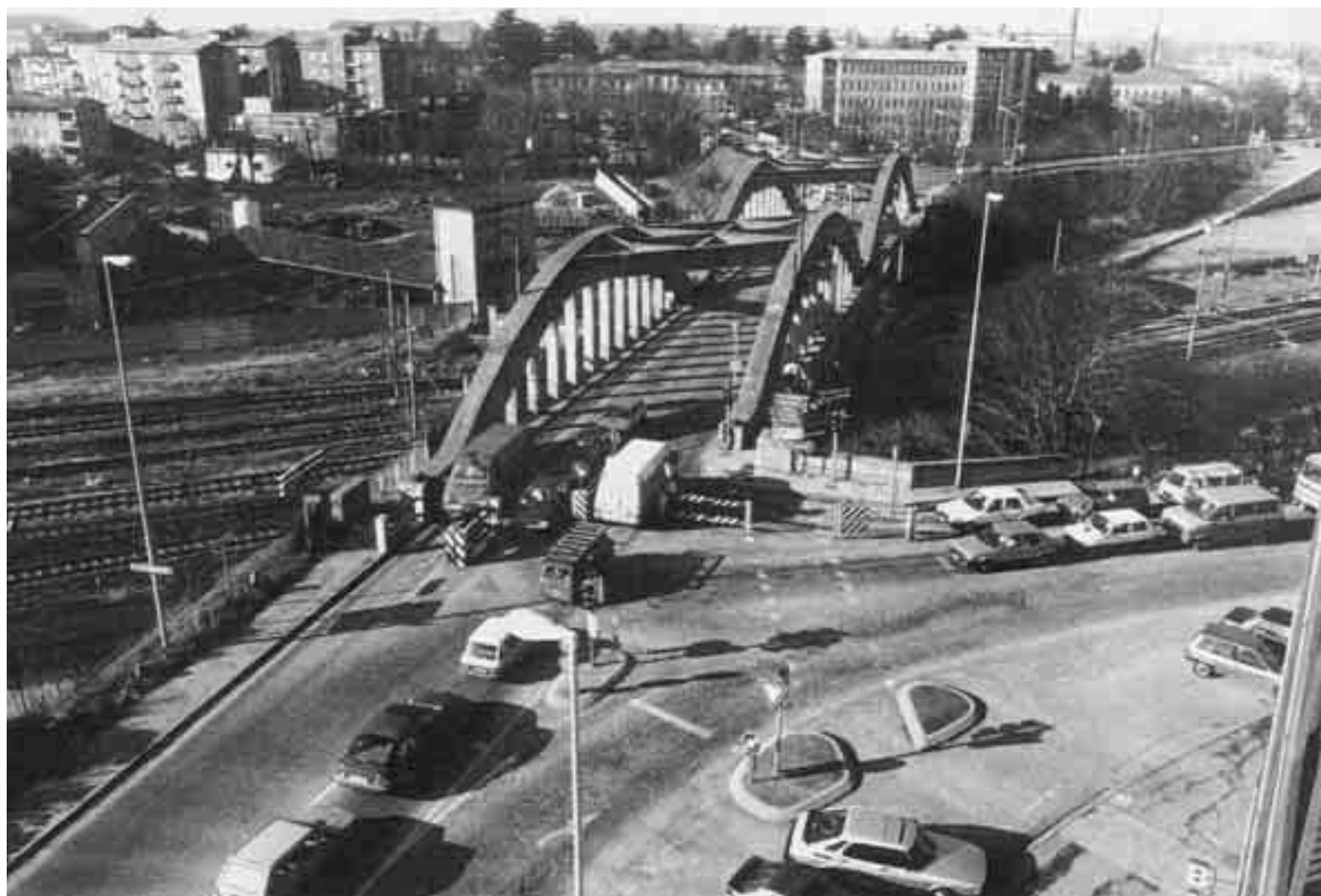
Il vecchio sovrappasso ferroviario, che portava al Policlinico San Matteo, costruito nel 1931, è stato demolito nel 1987 per dare spazio alla rotonda dei Longobardi con l'imponente scultura di Carlo Mo, il grande artista recentemente scomparso.
