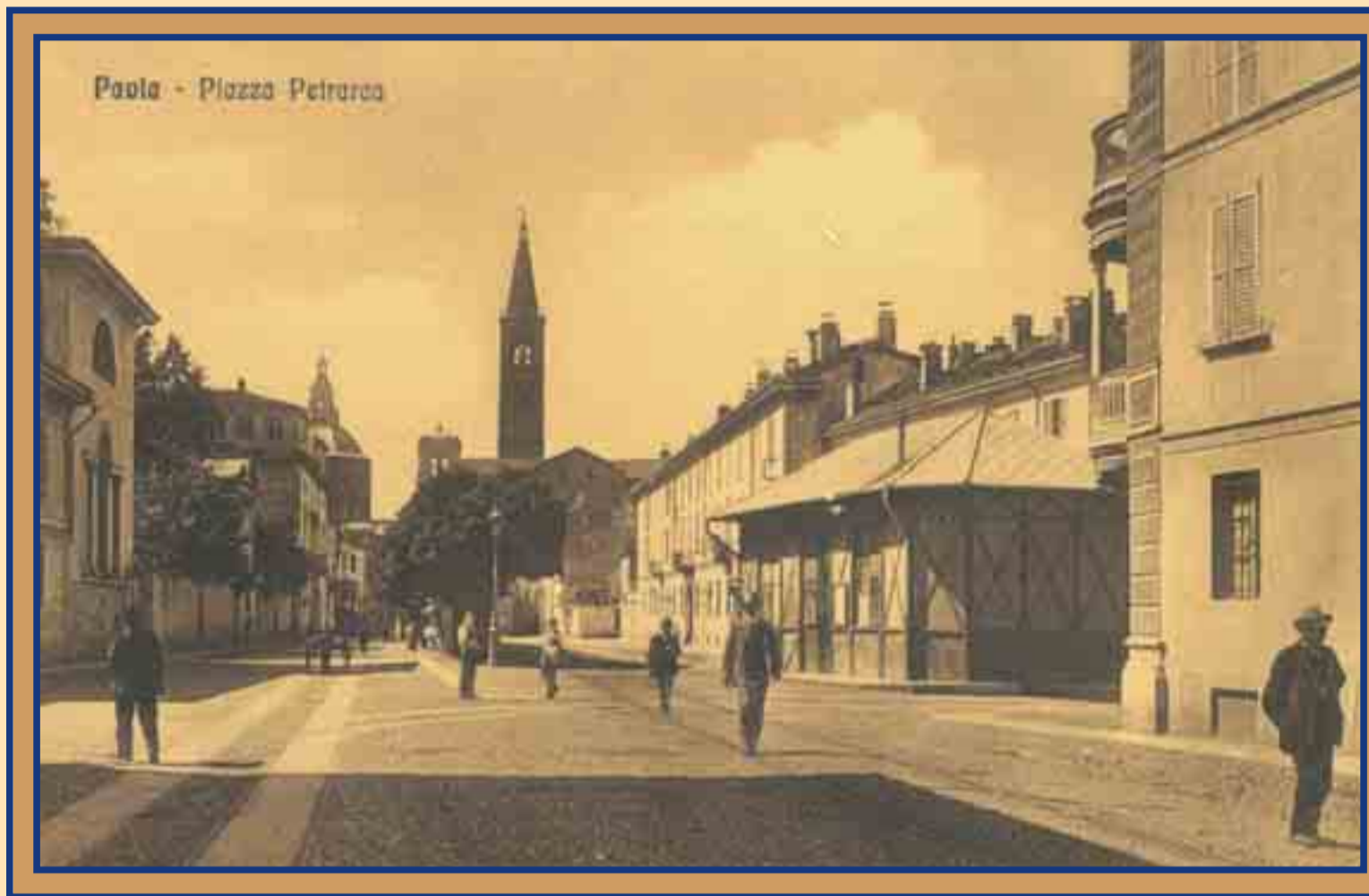
Anni Venti - Piazza Petrarca. Una tranquilla veduta mattutina. Sulla destra il basso edificio della stazione del "Gamba de Legn".
